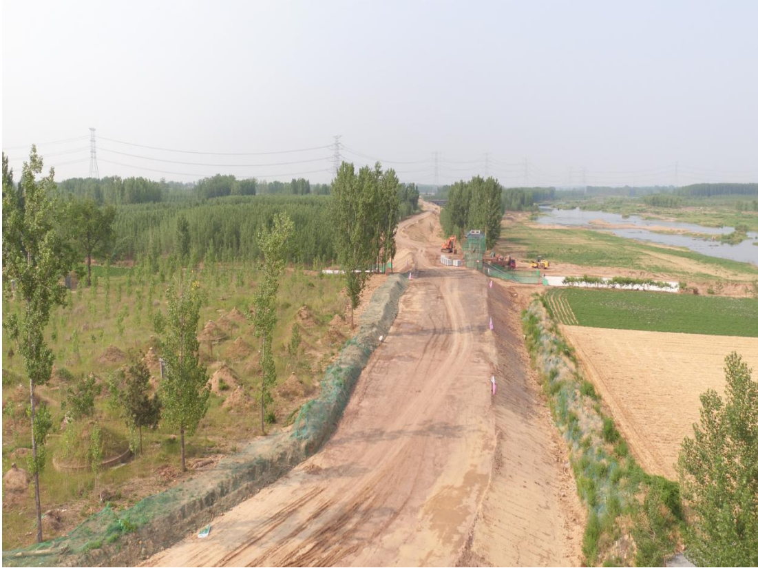
堤防表土剥离，沿堤防带状堆置并进行临时覆盖
