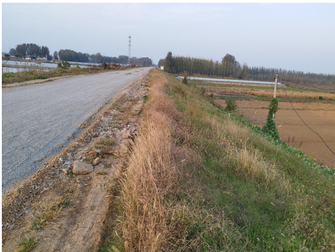
新兴河旁干流堤防边坡植物防护措施
