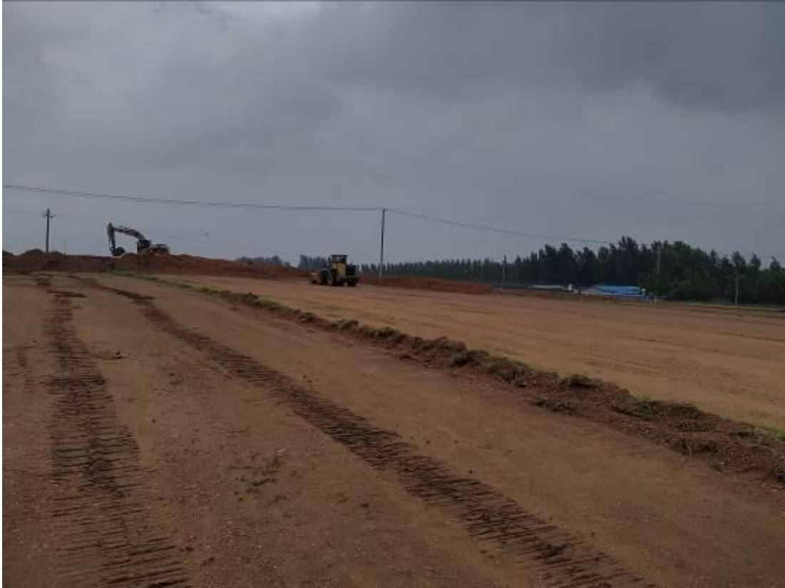
南石杭料场表土剥离
