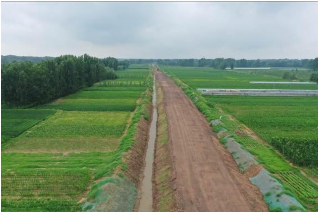
堤防表土剥离，沿堤防带状堆置并进行临时覆盖
