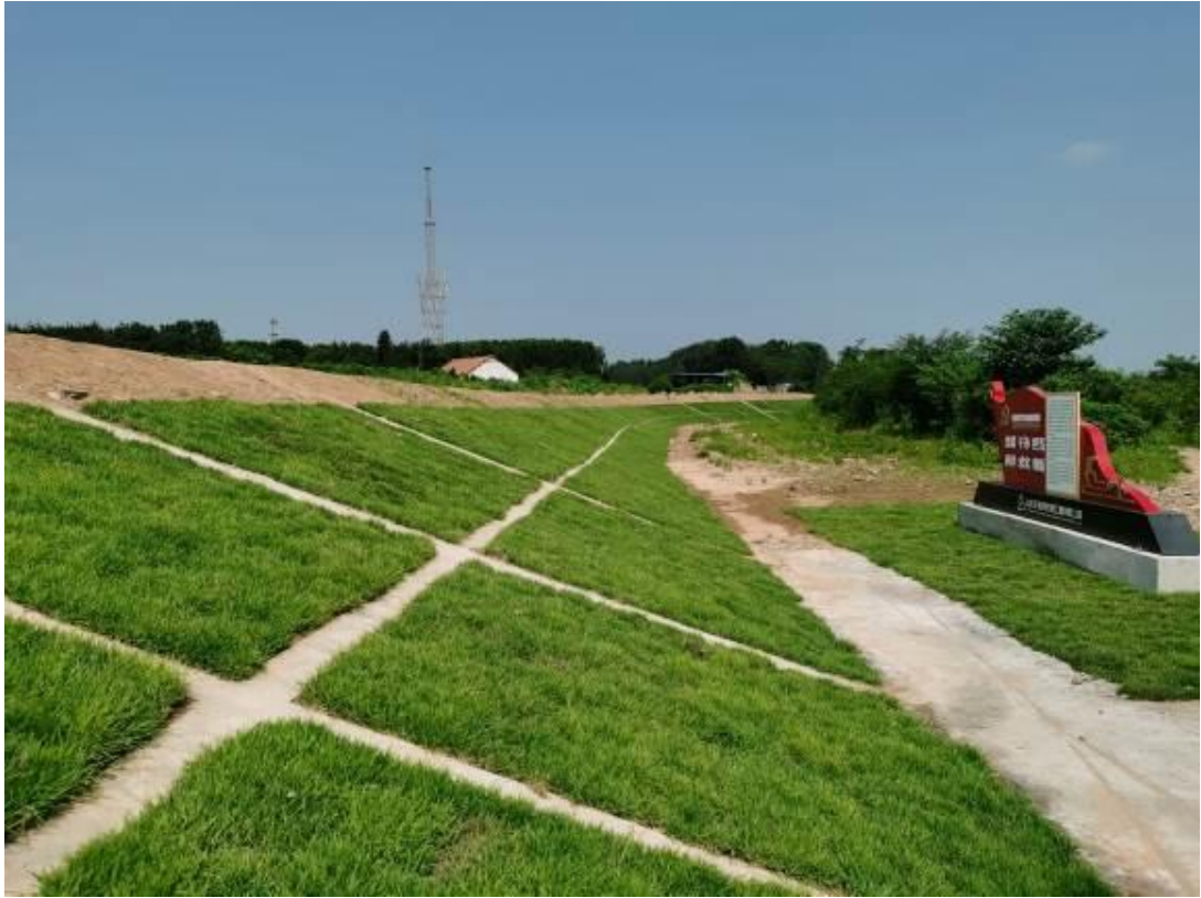
抗冻植被混凝土生态护坡
