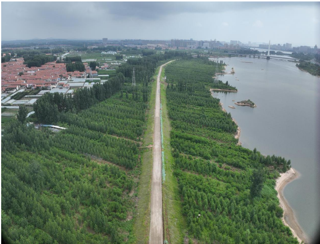
港埠口段干流堤防
