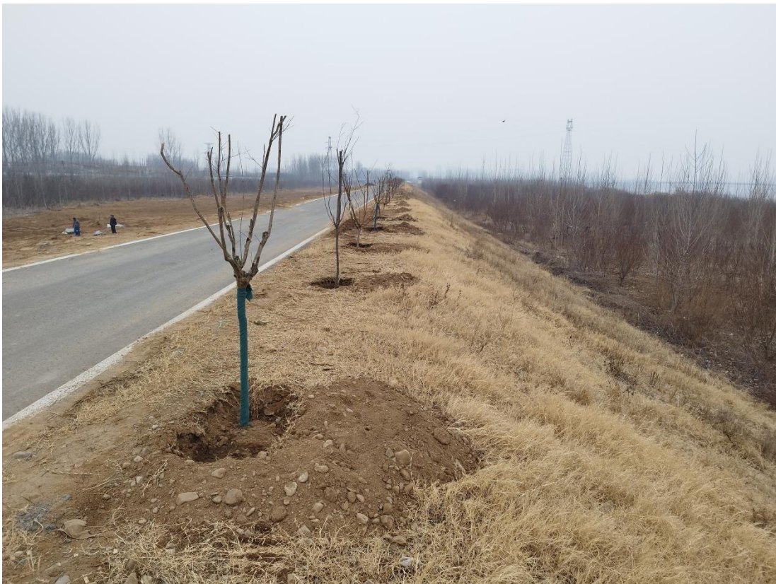
沿堤顶种植乔木，边坡撒播草籽植物防护
