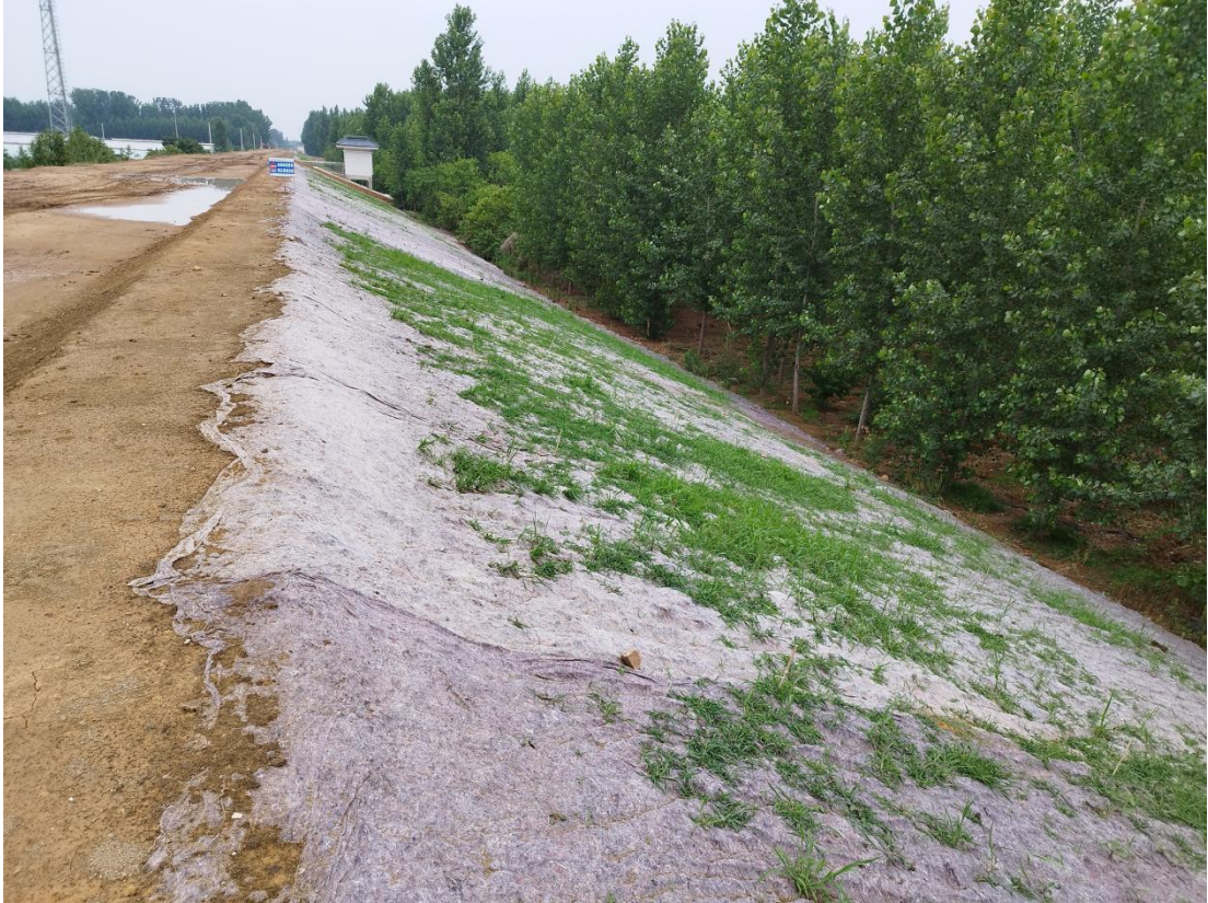
堤防边坡撒播草籽后采取临时覆盖措施，防止边坡雨水冲刷，提高草籽成活率
