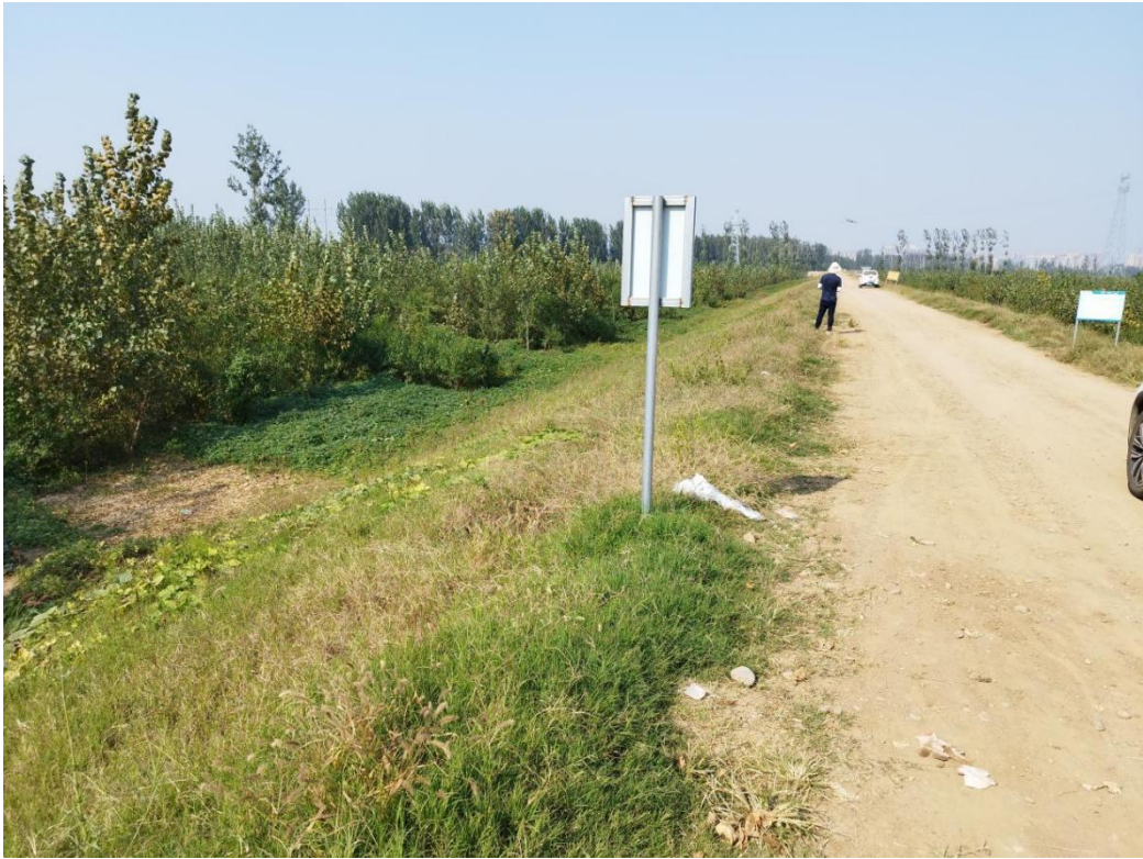
堤防边坡近景照片
