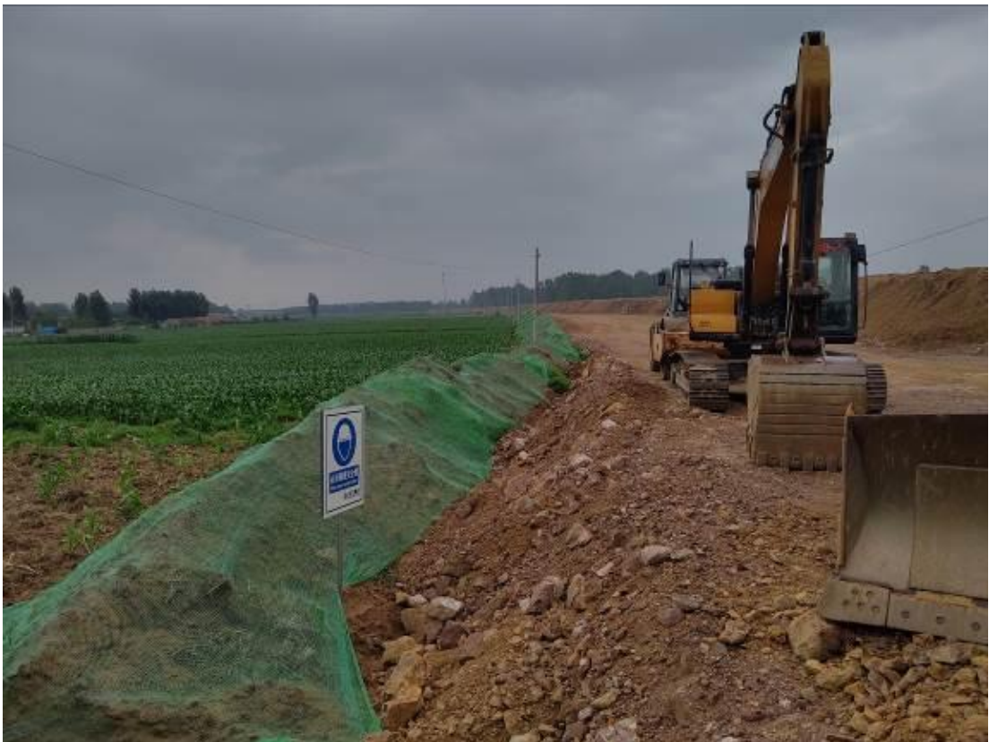
堤防剥离表土临时覆盖
