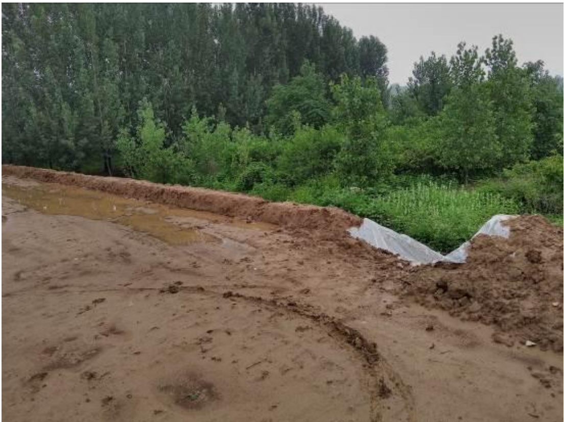
堤防临时简易纵向排水沟
