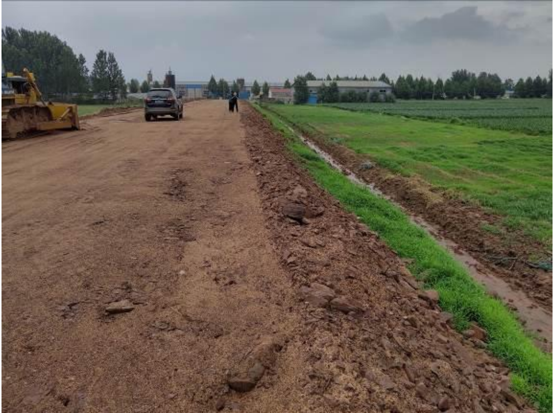
柳青河支流堤防临时排水沟
